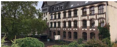
Seite 30 | Grundschule Schulhofsanierung
