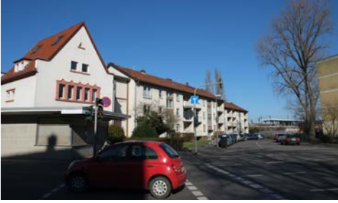
Die Häuser am Bahndamm werden demnächst abgerissen FOTO: H. FRINGS
