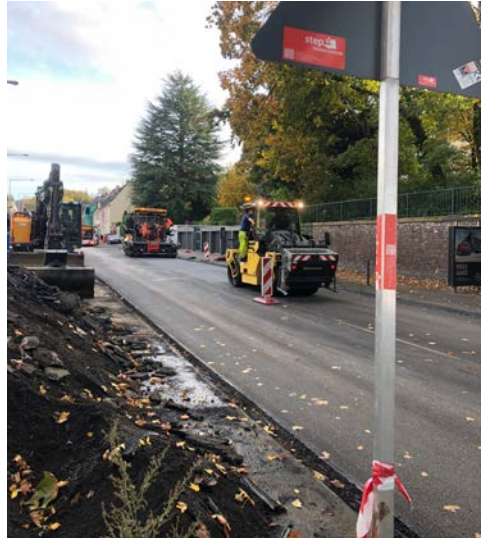
Sanierung der Fahrbahndecke auf dem Alten Militärring
