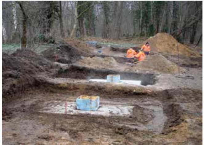
Vier tragfähige Betonfundamente
