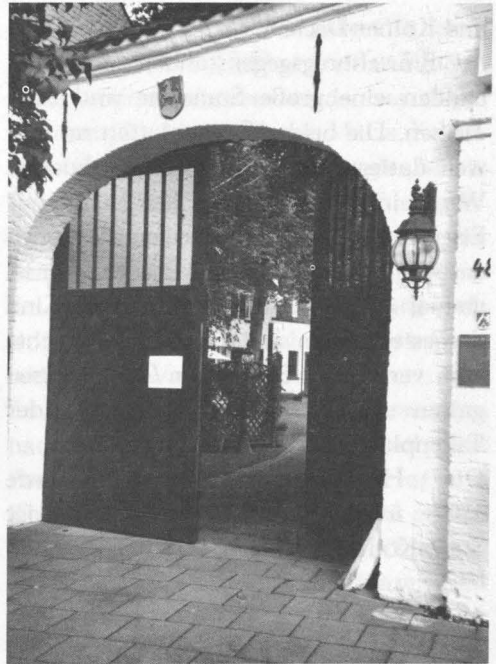
Tor zum Innenhof des Kirchenhofs (links die Remise)
