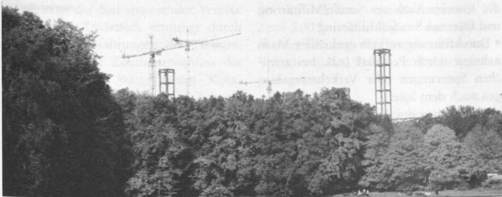
Mit großem Interesse verfolgen wir Müngersdorfer die Aktivität der Baukräne und das Emporwachsen der Pylone des neuen Stadions.
