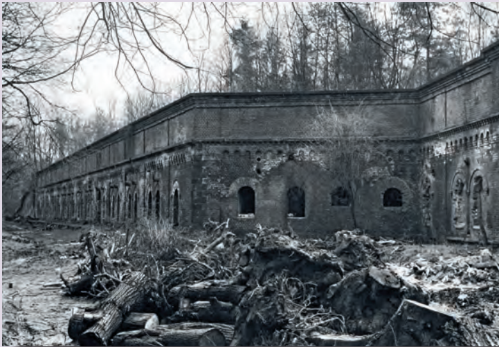
Mitteltrakt mit Abschluss des linken Seitenflügels der Kehlbasar von Fort V kurz vor der Sprengung 1962
